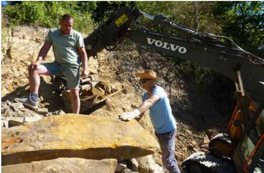
Abb. 35 - Paolo und der Kranführer Julien bei der Verlegung des eisenhaltigen Diest-Sandsteins.
