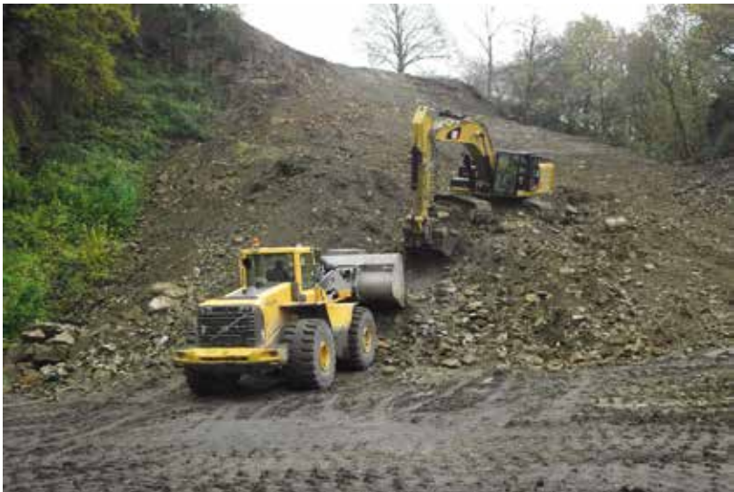
Abb. 3 - Inangriffnahme der Baustelle.
