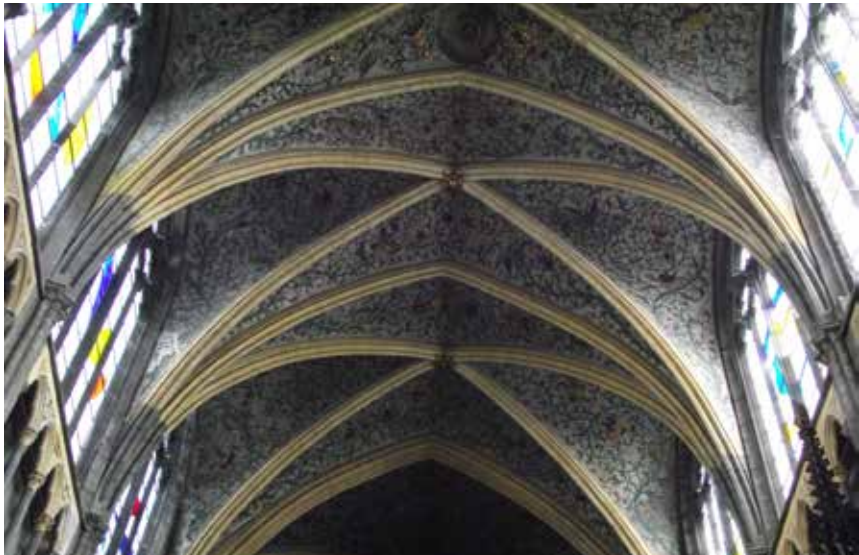
Abb. 22 - Die Gewölbe der Kathedrale Saint-Paul in Lüttich. Die Rippen bestehen aus bajocischem Kalkstein aus Dom-le-Mesnil.
