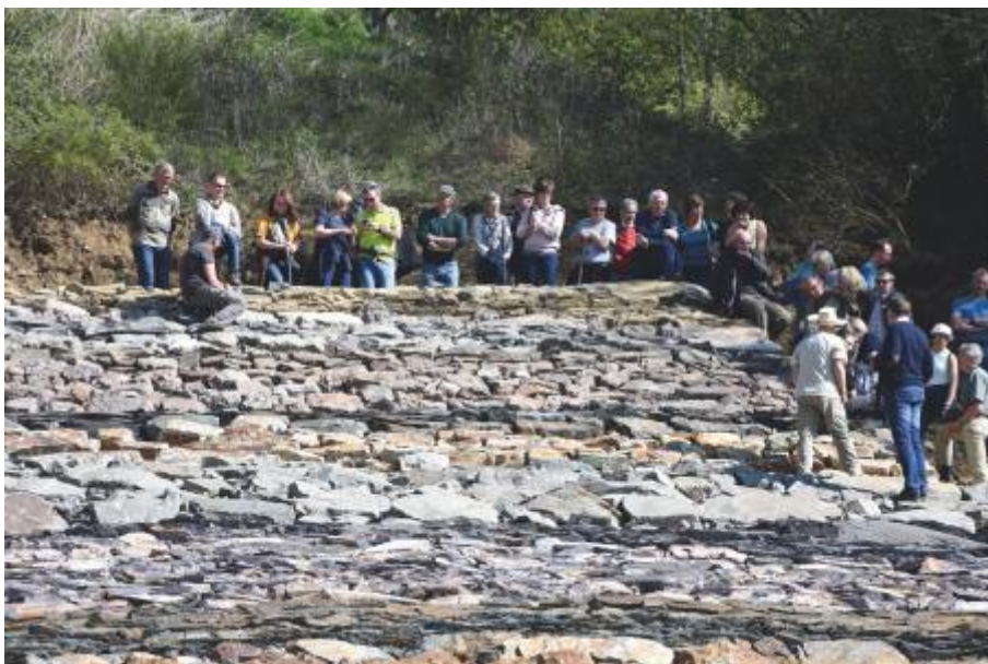
44. Een bezoek tijdens de plaatsing van de Famenniaanzandstenen (okergele kleur bovenaan de constructie).
