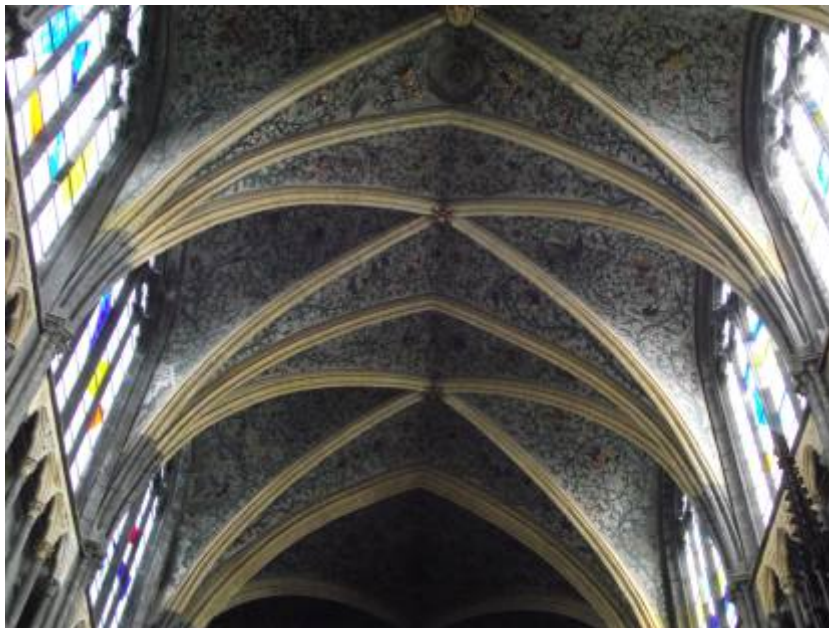
22. De gewelven van de Sint-Pauluskathedraal in Luik. De ribben zijn gemaakt in Bajociaan kalksteen van Dom-le-Mesnil.
